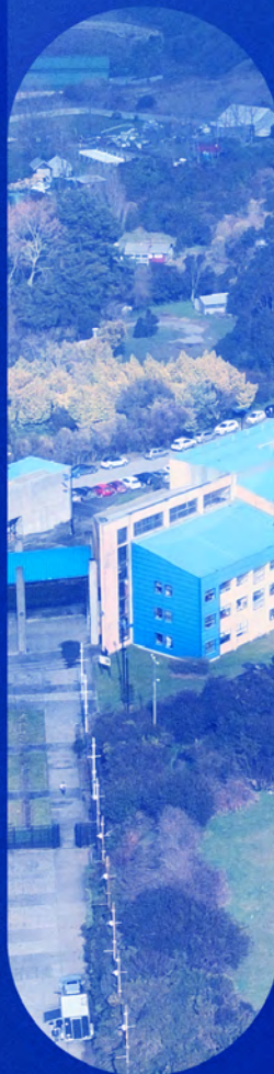
CÁMPUS PUERTO MONTT
